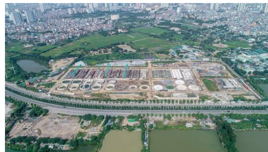
エンサ下水処理場(上空写真)
